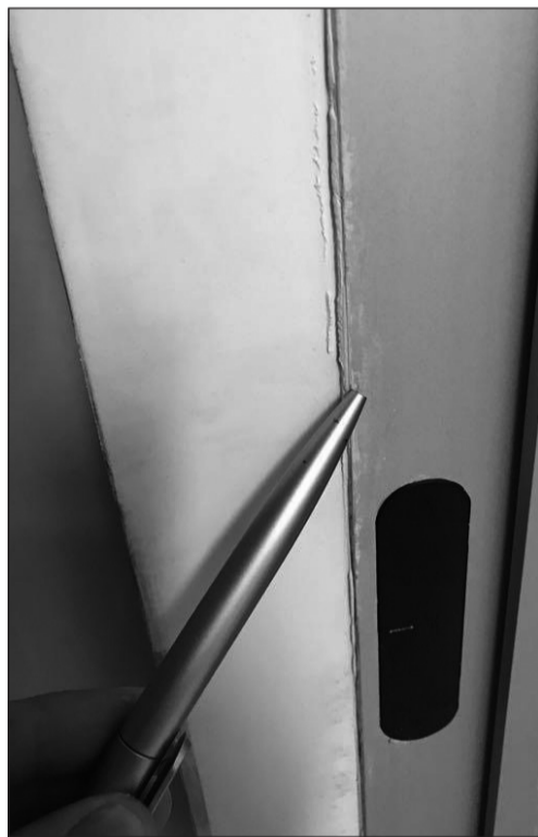
porta filo muro con telaio di spessore inferiore alla parete porta filo muro con telaio anodizzato
