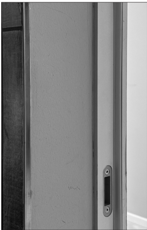
porta filo muro con telaio di spessore inferiore alla parete porta filo muro con telaio anodizzato
